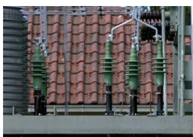
AFN20 для кабелей малого и большого сечения
