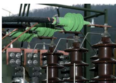
AFN10 для подсоединения к трансформаторам
