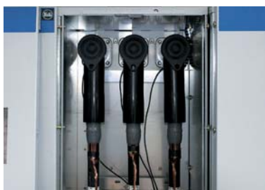
Элемент SF-6 для подсоединения к электроустановке с помощью 430ТВ
