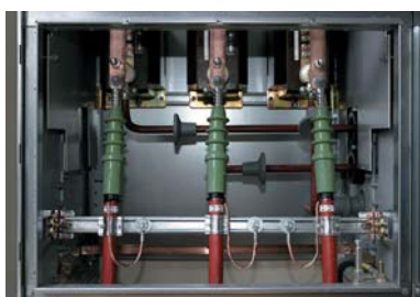
AIN20 с кабельным наконечником под опрессовку
