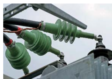
AFN20 для подсоединения к трансформаторам
